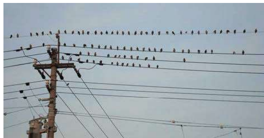
図4：松阪駅近くの電柱の様子
