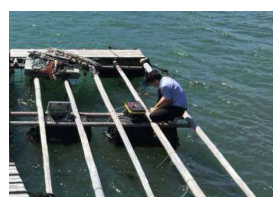
鳥羽市の筏にシステムを設置している様子
