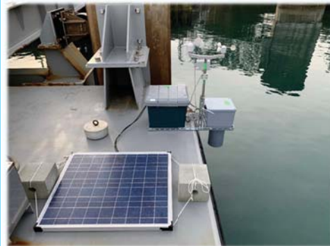
図4. ポンツーンに設置した様子
